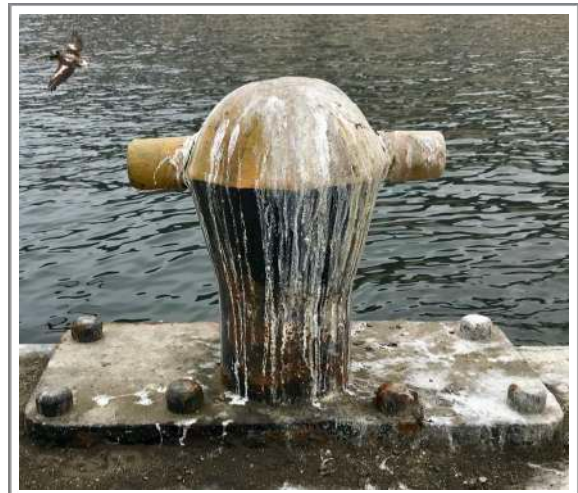
Bitas de Muelle Fuente: Foto Propia
